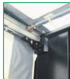
Verschraubter Knotenpunkt vorn Bolted junction front
