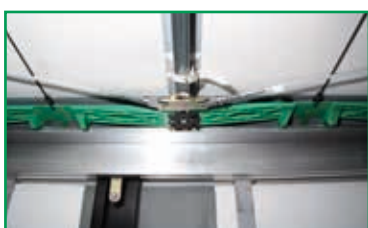
Dachaussteifung Roof reinforcement
