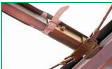
Rollenwagen mit Seilanbindung und Planenbefestigung Glider with cable connection and tarpaulin attachment
