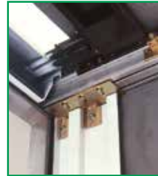
Verschraubter Knotenpunkt hinten Bolted junction rear
