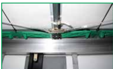
Dachaussteifung Roof reinforcement
